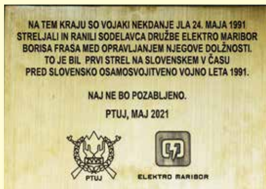
Spominska plošča na transformatorju (Foto: Boštjan Rous)
